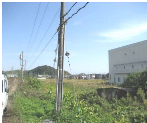
信号ケーブルの更新
