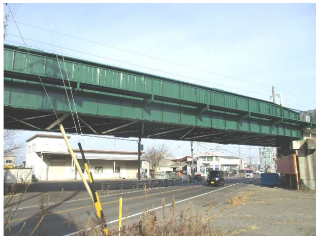
橋りょうの延命化(鈴鹿架道橋)
